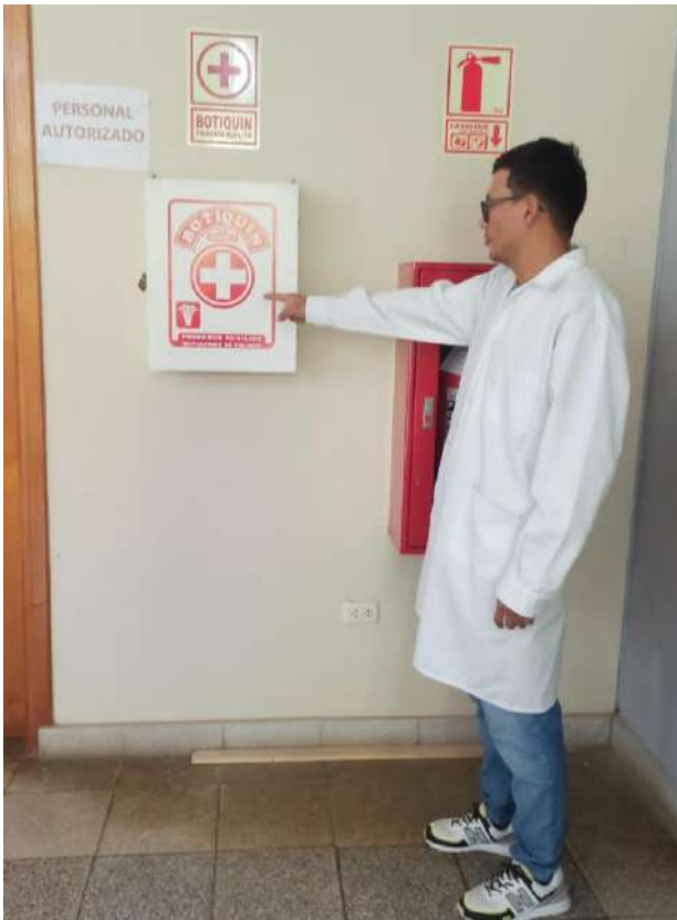
Figura 13 Inspección de botiquín, señalización y extintor
