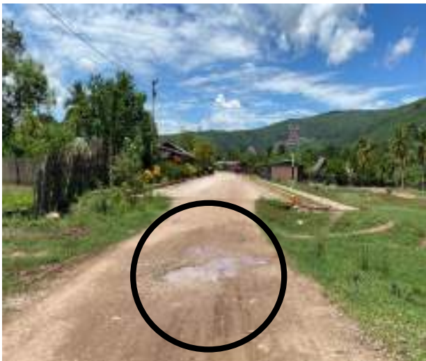
Figura 23 Progresiva 2 + 840 inicio de tramo con pavimento rígido
