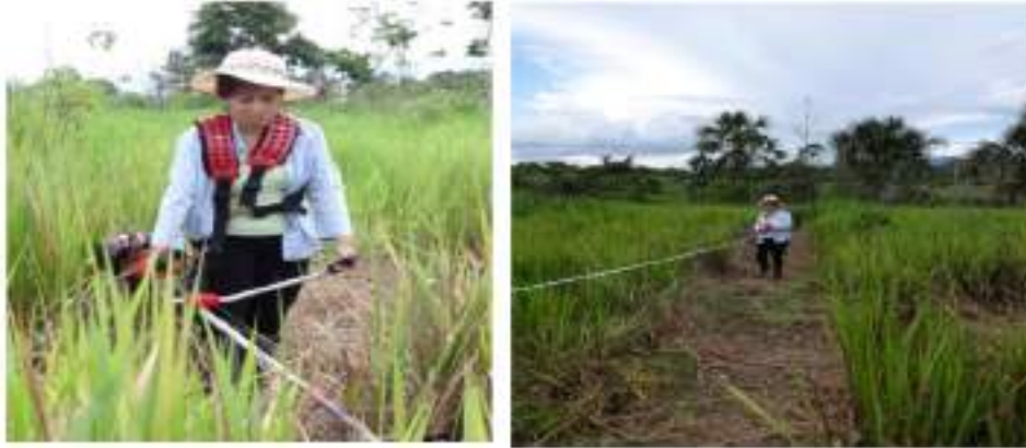
Figura 3 Limpieza del terreno
