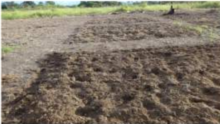
Figura 4 Preparación del terreno
