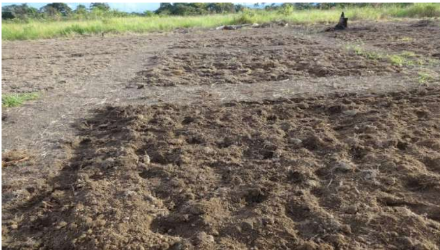
Figura 4 Preparación del terreno
