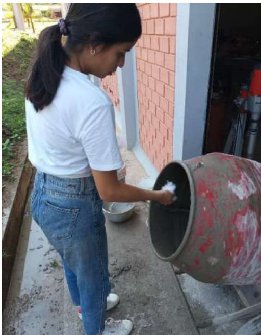
Foto 3: Adición de la fibra sintética a la mezcla.
