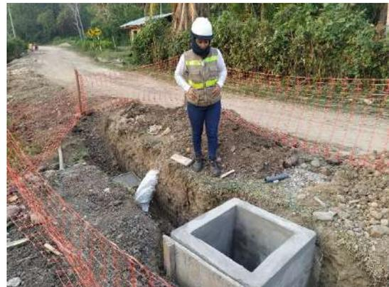
Fotografía 4. Colocación de cajas de registro
