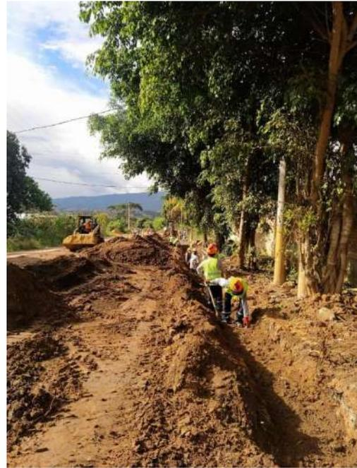
Fotografía 7. Excavación manual de zanjas
