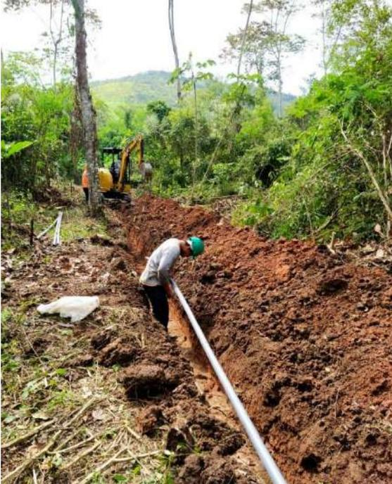
Fotografía 1. Actividad de colocación de tuberías
