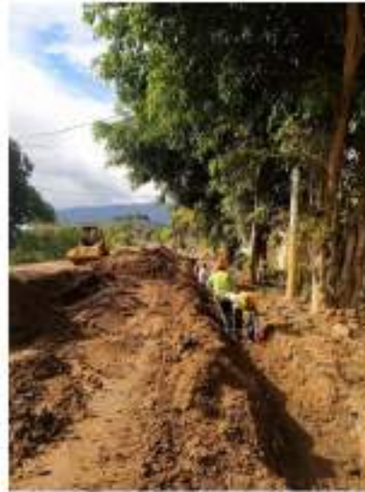
Fotografía 7. Excavación manual de zanjas
