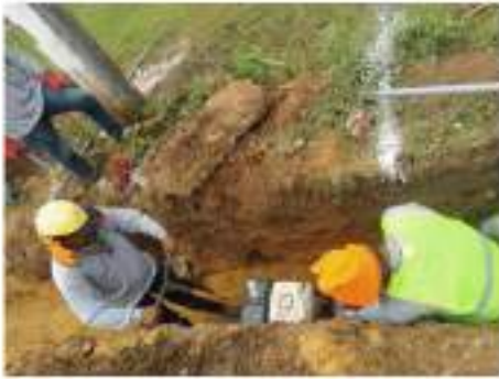
Fotografía 5. Relleno de zanjas
