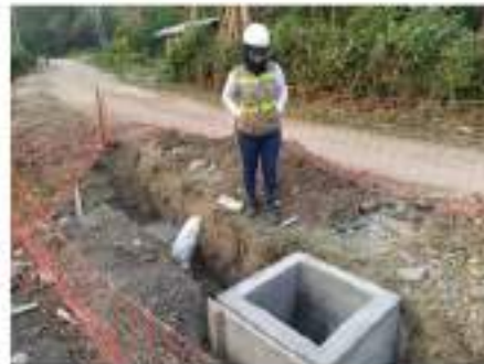
Fotografía 4. Colocación de cajas de registro
