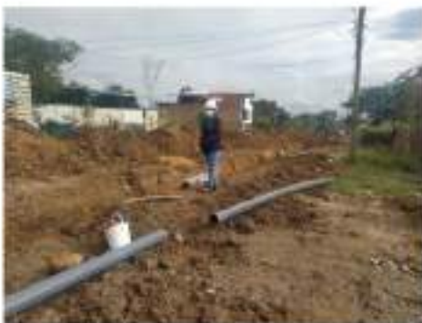
Fotografía 2. Observación del tendido de redes
