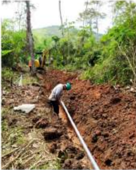
Fotografía 1. Actividad de colocación de tuberías
