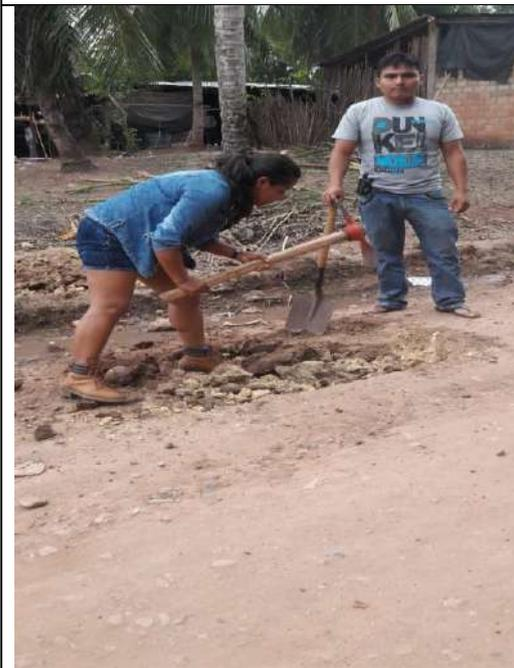
**Fotografía N° 03:** EXCAVACION DE MUESTRA N 10
