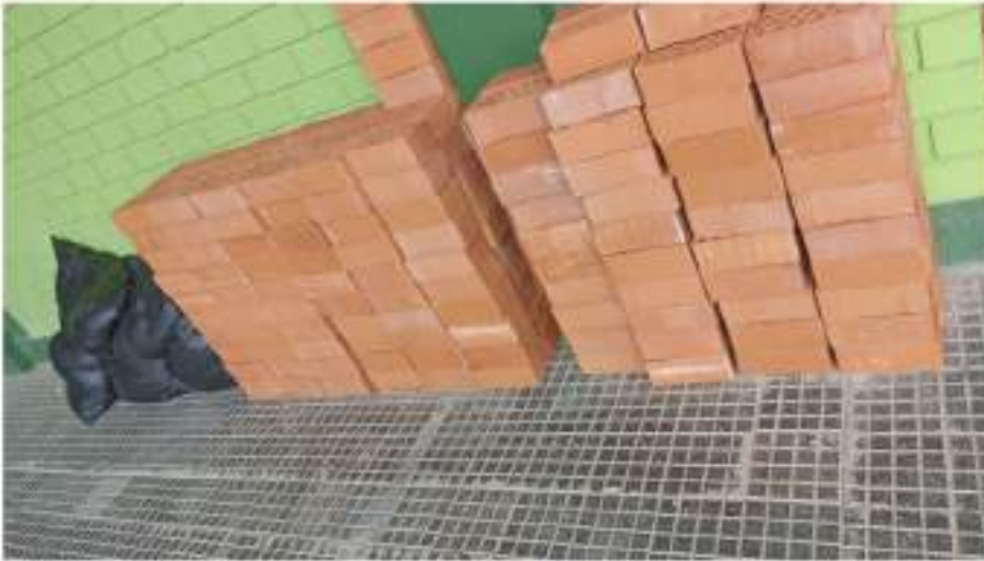
Fotografía N°1. Movilización de ladrillo King Kong 18 huecos y arena (cantera rio cumbaza) a la Universidad Nacional de San Martín.
