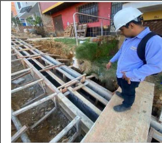
**Fotografía N° 09:** El tesista Bach. Abel Benavides Vásquez constatando el acabado final del encofrado en punto de descarga.
