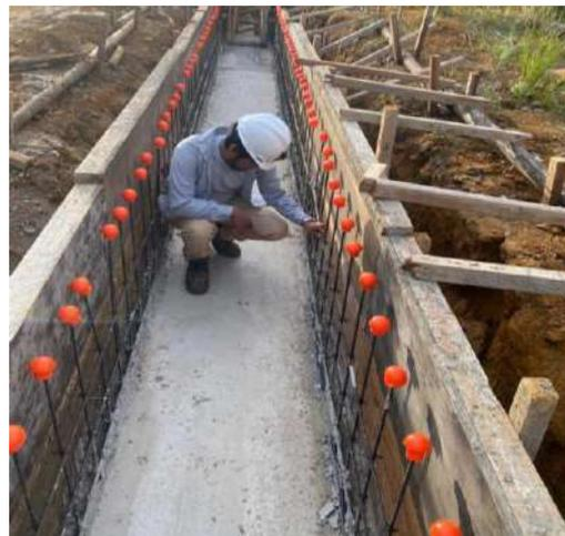
**Fotografía N° 08:** El tesista Bach. Nino Manuel Choccare Huamán constatando el acabado final de concreto F´C=175 Kg/cm2 en punto de descarga.
