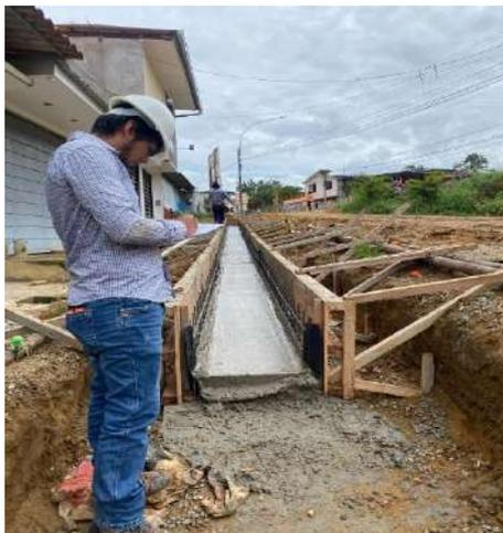
**Fotografía N° 07:** El tesista Bach. Nino Manuel Choccare Huamán constatando el acabado final de concreto F´C=175 Kg/cm2 en punto de descarga.
