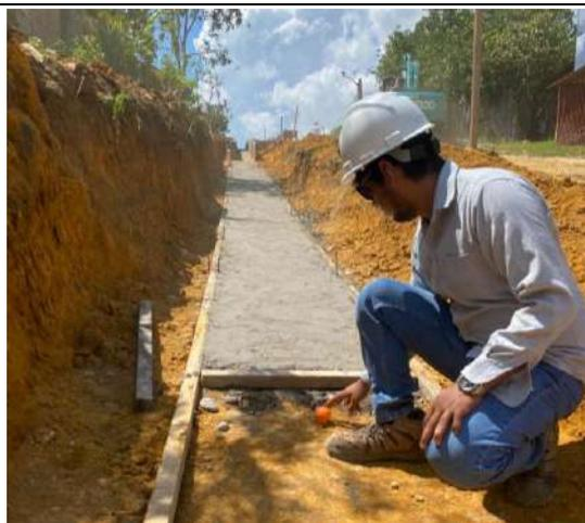
**Fotografía N° 06:** El tesista Bach. Nino Manuel Choccare Huamán constatando el acabado final de concreto F´C=100 Kg/cm2 para solado.
