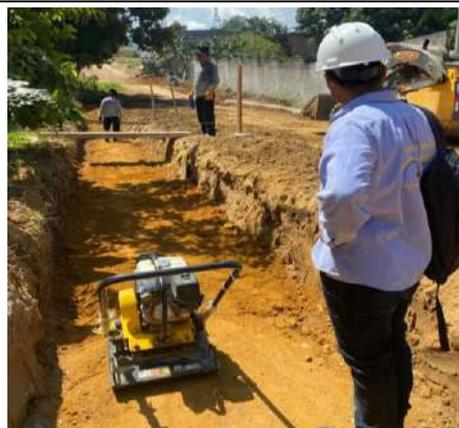
**Fotografía N° 04:** El tesista Bach. Abel Benavides Vásquez constatando el proceso del trabajo de relleno y compactación con material propio con equipo liviano.
