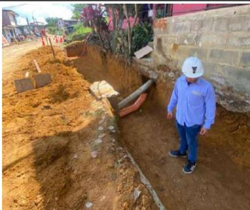
**Fotografía N° 03:** El tesista Bach. Abel Benavides Vásquez verificando el proceso de la actividad de excavación manual para cunetas.
