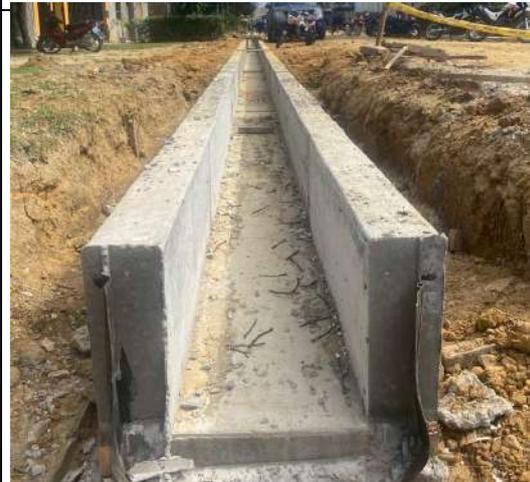
**Fotografía N° 12:** Vista de la estructura Cuneta Abierta.
