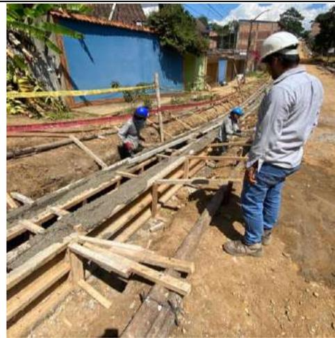
**Fotografía N° 10:** El tesista Bach. Nino Manuel Choccare Huamán constatando el proceso de la actividad de concreto  $F'C=175 \text{ Kg/cm}^2$
