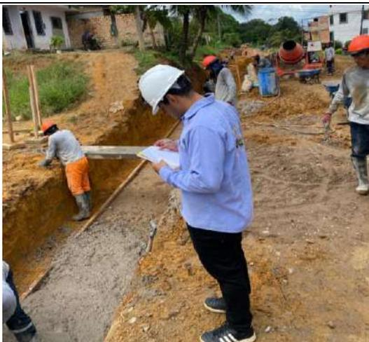
**Fotografía N° 05:** El tesista Bach. Abel Benavides Vásquez constatando el proceso de la actividad de vaceo de concreto F´C=100 Kg/cm2 para solado.
