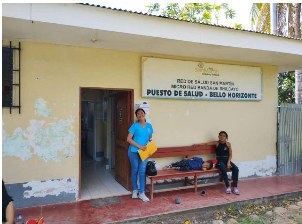
Figura 5 Puesto de Salud Bello Horizonte
