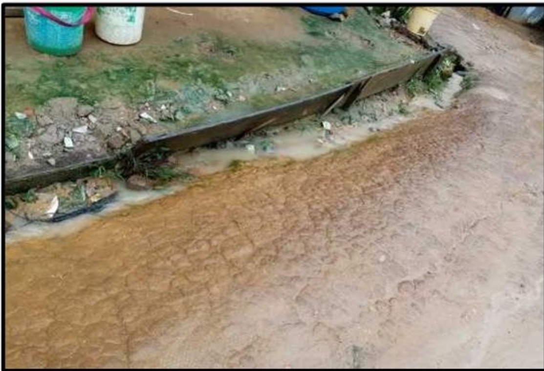
Foto 3: Un Mal sistema de drenaje pluvial es una fuente de contaminación y foco infeccioso.
