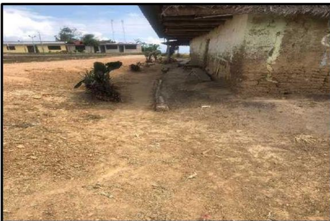
Foto 4: Se puede observar la inexistencia del sistema de drenaje pluvial en la localidad de aocaloma.
