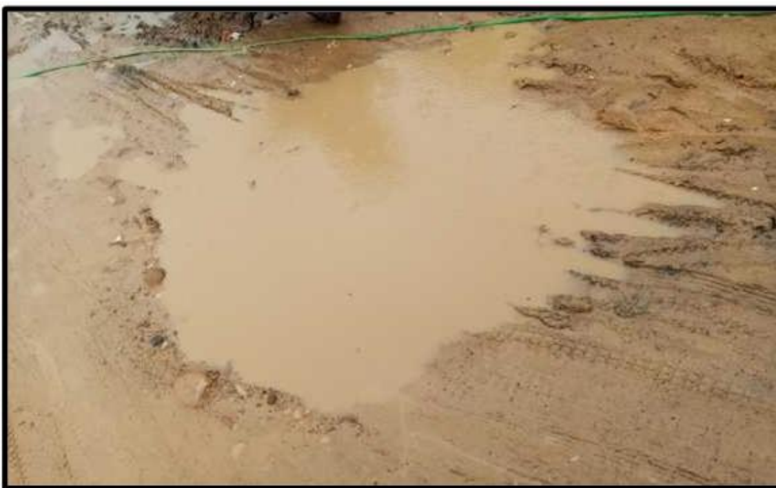
Foto 2: Se aprecia un estancamiento en las calles ya que el Sistema de Drenaje no es capaz de evacuar eficientemente el agua en el caserío de aocaloma.
