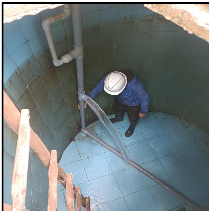
Fotografía N° 3. Finalización de la Instalación del nivel estático en reservorio.
