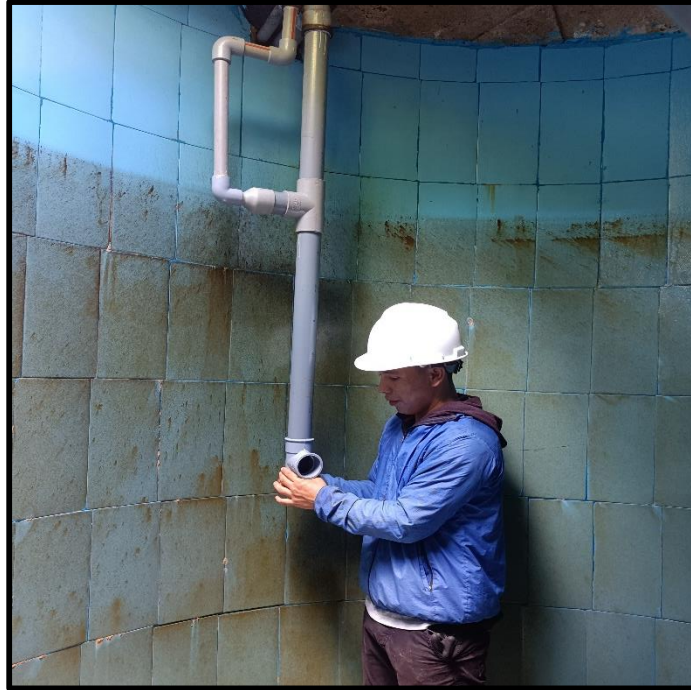
Fotografía N° 1. Instalación del nivel estático en reservorio.
