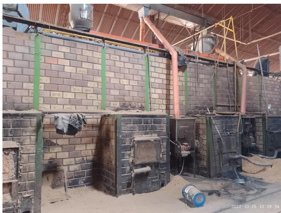
Foto 4: Sección del horno túnel
