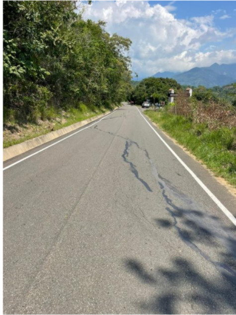
Fotografía 11. Se visualiza una sección del tramo de estudio en el cual se realizaron trabajos de mantenimiento.
