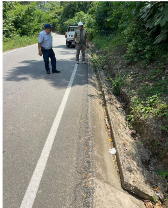
Fotografía 18. Se visualiza al tesista y al asesor de tesis inspeccionando las patologías ocasionadas por falta de mantenimiento de parte de la Entidad encargada del tramo de estudio
