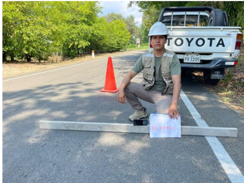
Fotografía 6. Se observa al tesista la progresiva KM 3+950, indicando que no existen patologías.
