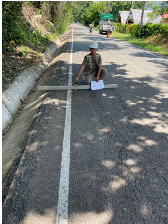
Fotografía 12. Se observa al tesista identificando la patología de piel de cocodrilo de gravedad 3, en la progresiva KM 5+300.
