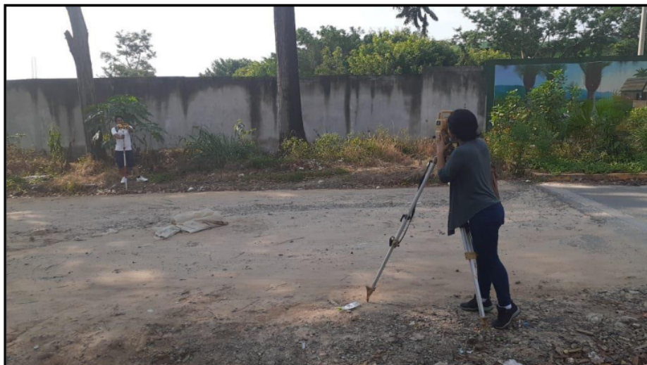
Figura 223. En la imagen se aprecia el Levantamiento topográfico realizado con estación total, para tener una perspectiva más detallado de la zona (Fuente: Elaboración propia)
