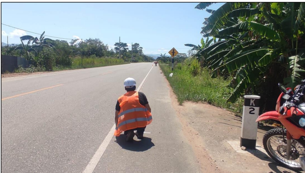
Figura 30. Medición del Tramo 1 (2+000 KM - 2+320 KM) para levantamiento topográfico. Fuente: Elaboración propia.
