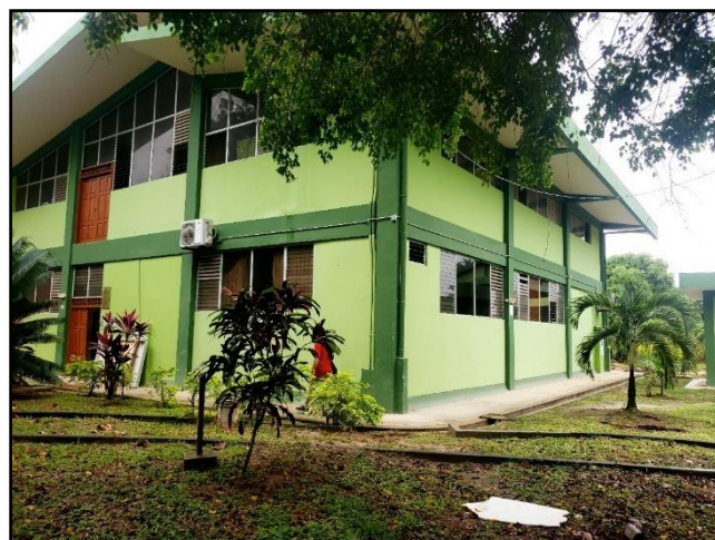
Foto N° 02: Pabellón Administrativo 01 de la Facultad de Ingeniería Agroindustrial (Fuente: Elaboración propia)
