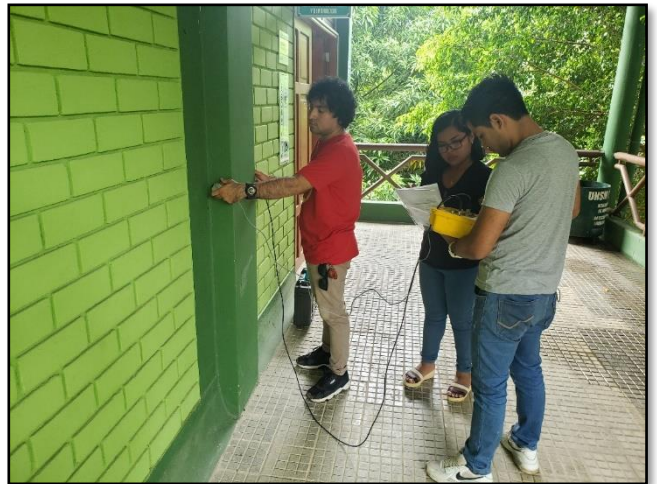
Foto N° 23: Realizando el ensayo de ultra sonido con el equipo electrónico en las columnas del Pabellón de Aulas de la Facultad de Ciencias Agrarias (Fuente: Elaboración propia)
