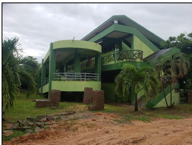
Foto N° 01: Pabellón de Aulas de la Facultad de Ciencias Agrarias (Fuente: Elaboración propia)
