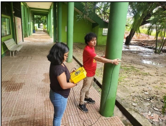
Foto N° 22: Realizando el ensayo de ultra sonido con el equipo electrónico en las columnas del Pabellón de Laboratorios y Gabinetes de la Facultad de Ciencias Agrarias (Fuente: Elaboración propia)
