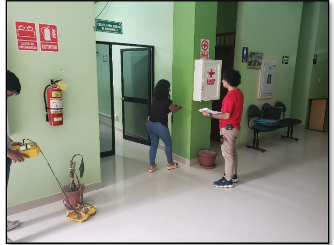
Foto N° 21: Realizando el ensayo de esclerometría con el equipo electrónico en las columnas del Pabellón Administrativo 01 de la Facultad de Ingeniería Agroindustrial (Fuente: Elaboración propia)
