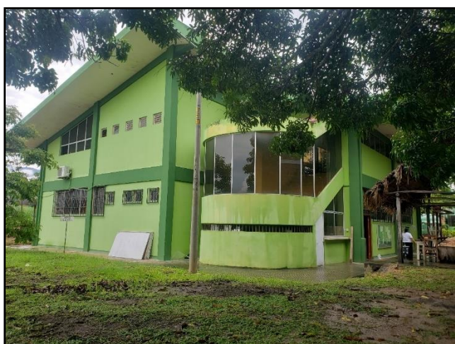
Foto N° 03: Pabellón Administrativo 02 de la Facultad Ingeniería Agroindustrial (Fuente: Elaboración propia)
