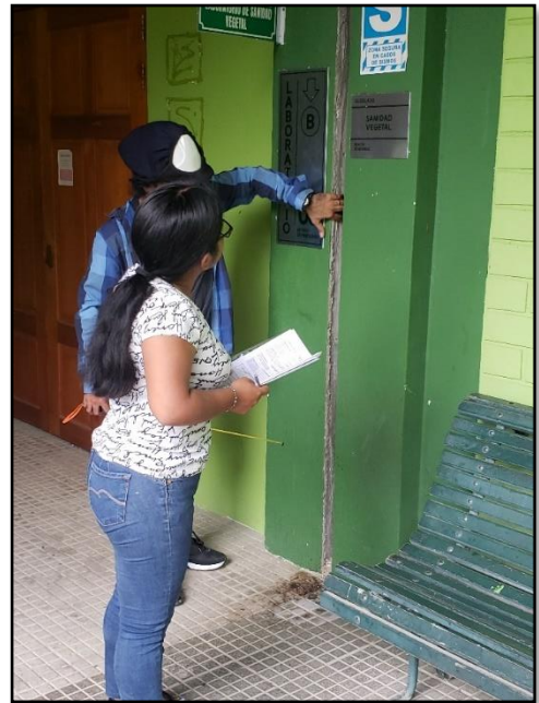
Foto N° 06: Toma de datos In situ la realizar la evaluación por el método de Hirosawa del primer nivel del Pabellón de Laboratorios y Gabinetes de la Facultad de Ciencias Agrarias (Fuente: Elaboración propia)
