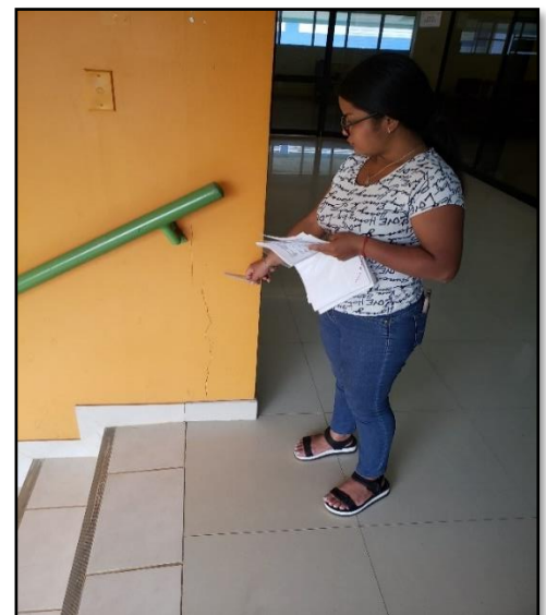
Foto N° 08: Toma de datos In situ para realizar la evaluación por el método de Hirosawa del segundo nivel del Pabellón Administrativo 02 de la Facultad de Ingeniería Agroindustrial (Fuente: Elaboración propia)
