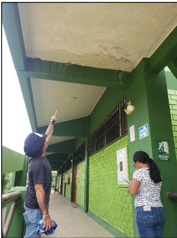
Foto N° 07: Toma de datos In situ para realizar la evaluación por el método de Hirosawa del segundo nivel del Pabellón de Aulas de la Facultad de Ingeniería Agroindustrial (Fuente: Elaboración propia)
