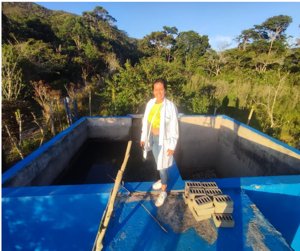
Fotografía 5. Breve inspección del reservorio
