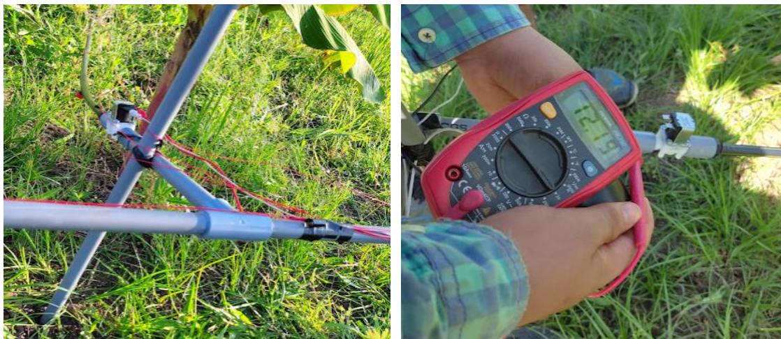
Figura 17. Instalación y testeo de las válvulas solenoide
