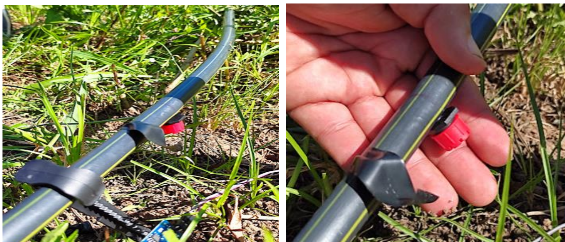
Figura 18. Instalación de la manguera de riego y goteros
