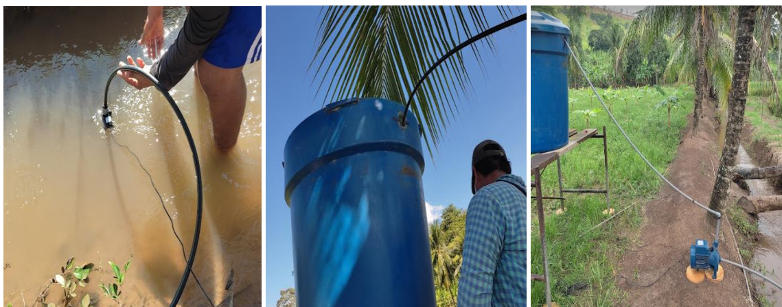
Figura 14. Instalación de la electrobomba
