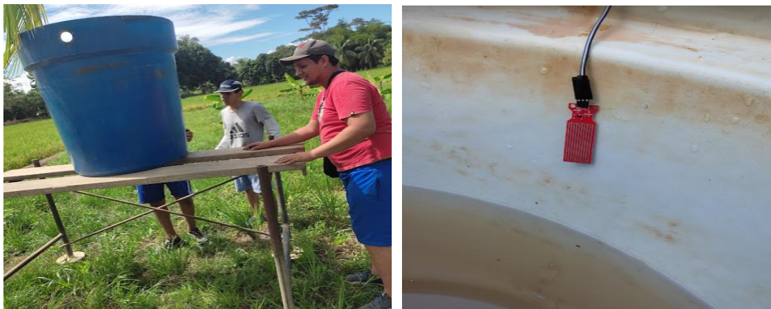
Figura 13. Instalación del tanque de agua y sensor de nivel de agua
