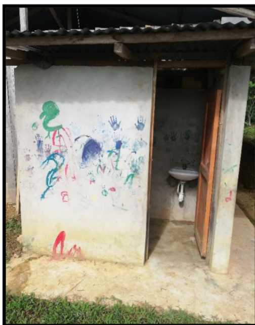
Fotografía 07. Servicios higiénicos de la Institución educativa inicial.
