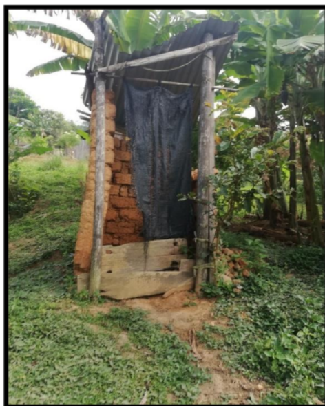
Fotografía 10. Servicios higiénicos de las viviendas en la comunidad, construidas de calamina, costales, adobe de barro para cubrir la parte superior.
