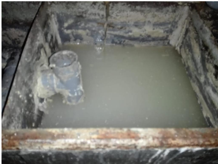
Fotografía 2. Parte media de la trampa de grasas
