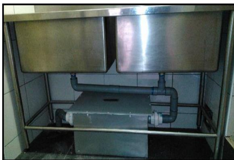
Figura 2. Trampa de grasa y aceites ubicación relativa Fuente: (Durman, 2012)
