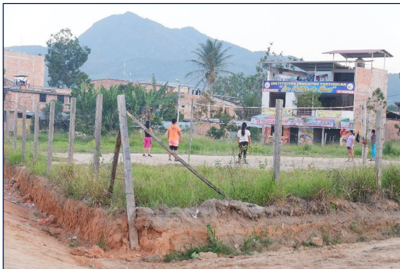
Figura 2: Fachada de un espacio público, sector 02. (Fuente: Elaboración propia)
