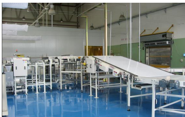
Figura 13. Túnel de refrigeración
