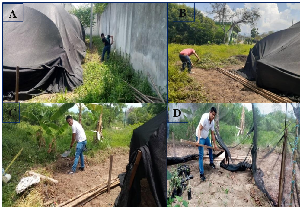
Figura 24: Establecimiento. A y B: Limpieza del perímetro del vivero, C y D: construcción de camas de crecimiento.
