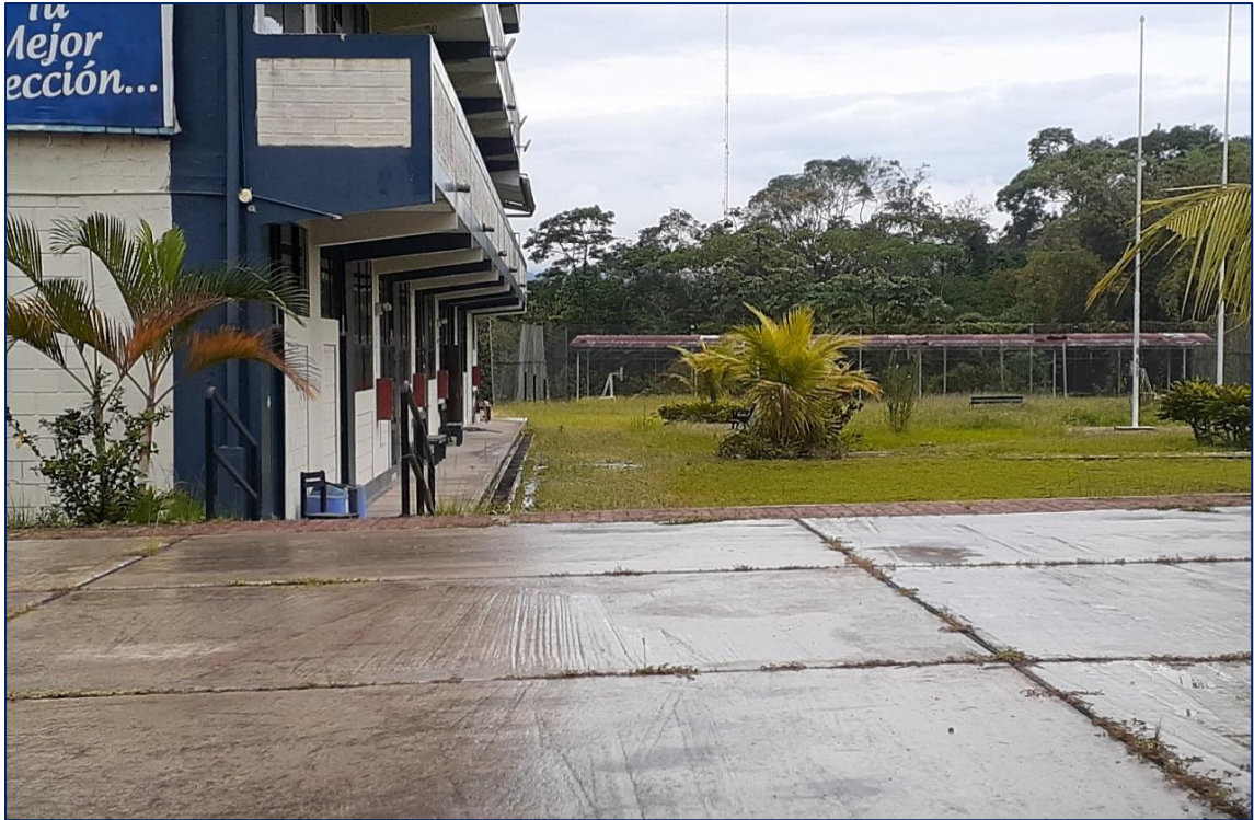
Fotografía 10. Losa principal de la I.E. Amae
