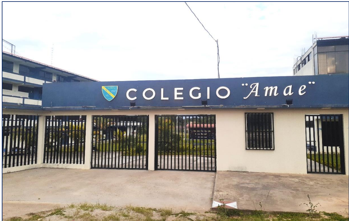
Fotografía 8. Ingreso principal de la I.E. Amae
