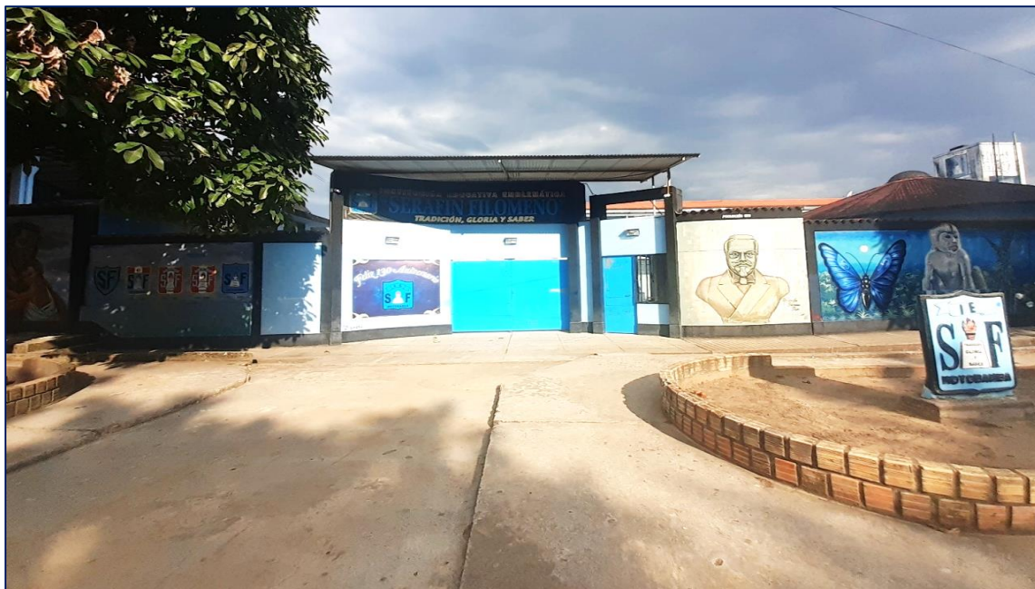
Fotografía 1. Ingreso principal a la I.E. Serafín Filomeno
