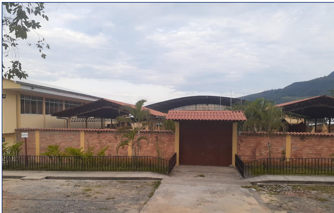
Fotografía 15. Ingreso principal de la I.E. Señor del Perdón
