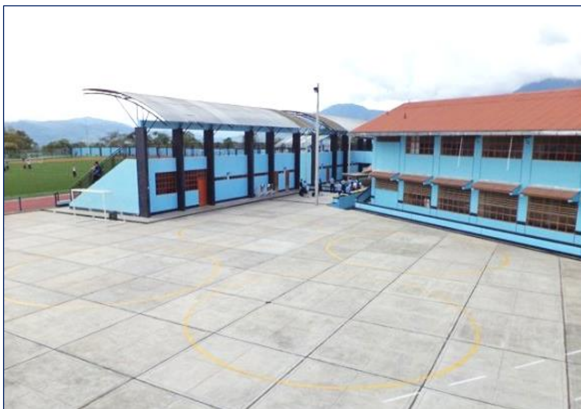
Fotografía 4. Losa principal I.E. Serafín Filomeno
