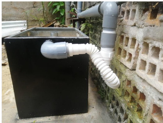
Fotografía 5. Instalación de accesorios.
