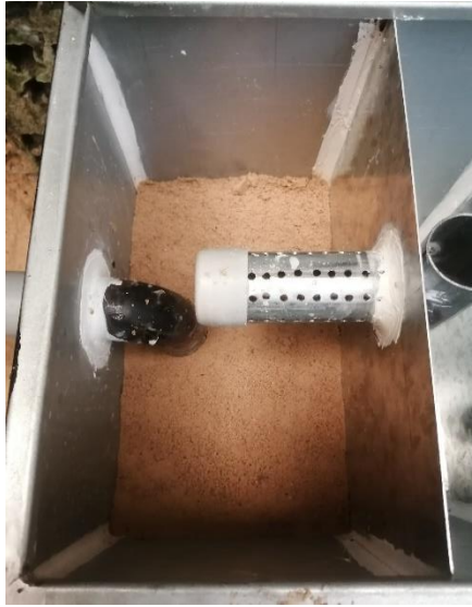
Fotografía 7. Colocación de capa de arena
