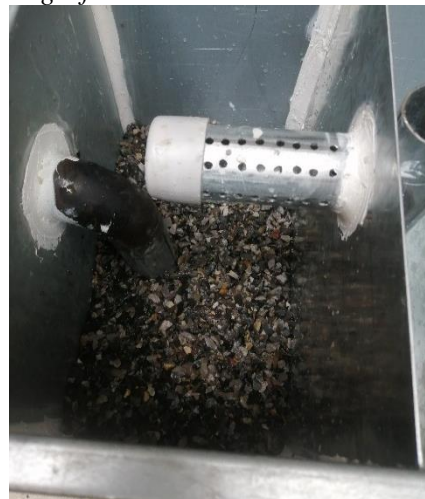
Fotografía 6. Colocación de capa de grava.
