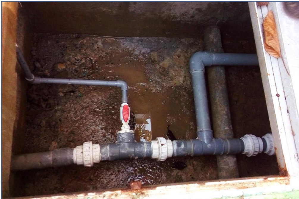
Fotografía 1. Estado de caja de valvulas.
