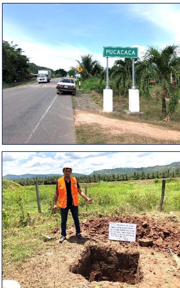
**Figura 30:** Excavación de Calicata C-01. (Fuente: Elaboración Propia)
