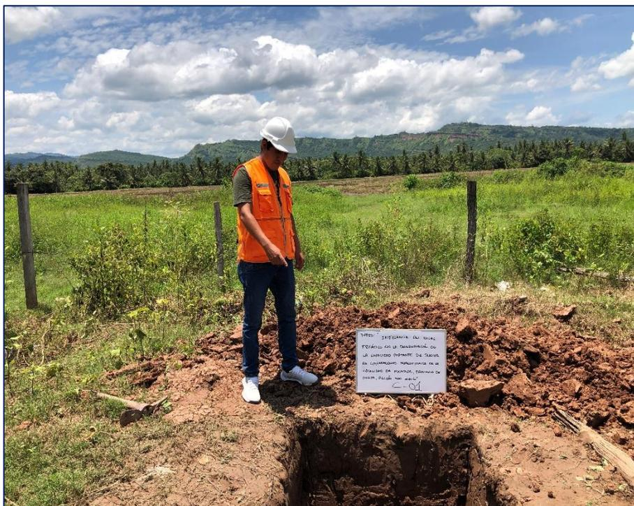
**Figura 56:** Vista de la calicata C-01, proceso de excavación. (Fuente: Elaboración Propia).
