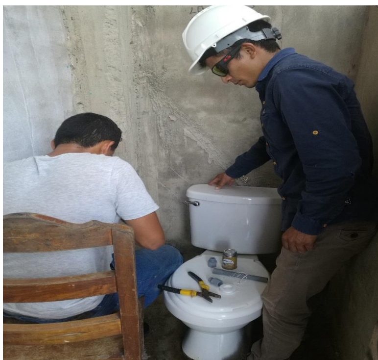
Fotografía 6: Conexión de la Tubería al Inodoro Sanitario
