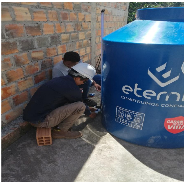
Fotografía 4: Instalación del Tanque (1100 l) de Almacenamiento de Agua de Lluvia
