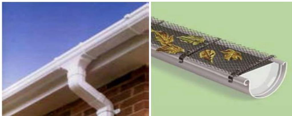
Figura 4. Canaletas de Recolección del Agua Pluvial. (Fuente: CEPIS, 2004. Guía de Captación de Agua de Lluvia).
