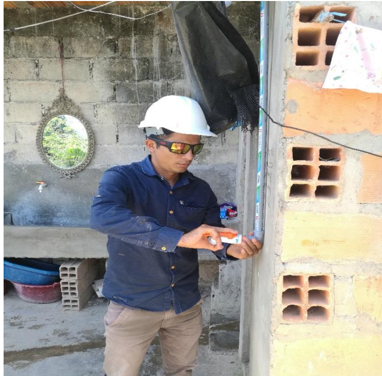
Fotografía 7: Instalación de pileta
