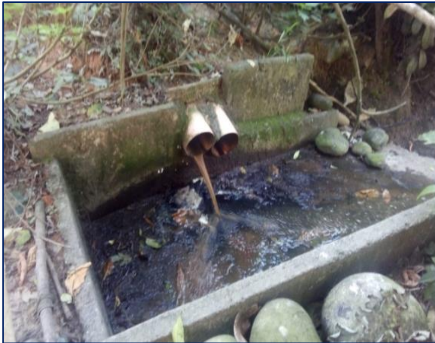
Fotografía 16. Agua residual que viene procedente del camal - teniendo un foco infeccioso
