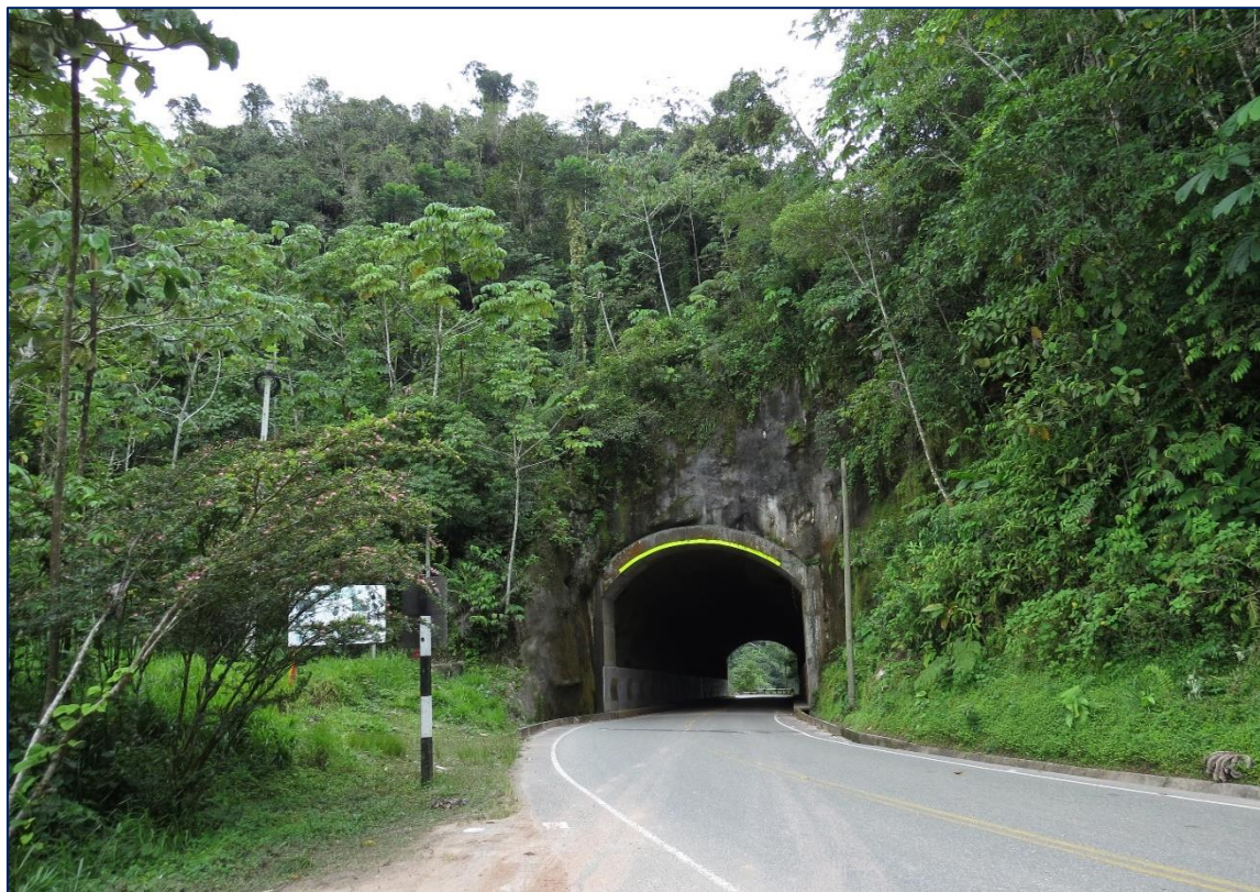
Foto 8. Carretera Tarapoto – Yurimaguas km 9 al km 20, Provincia de San Martín. (Fuente: Archivo propio, 2016).
