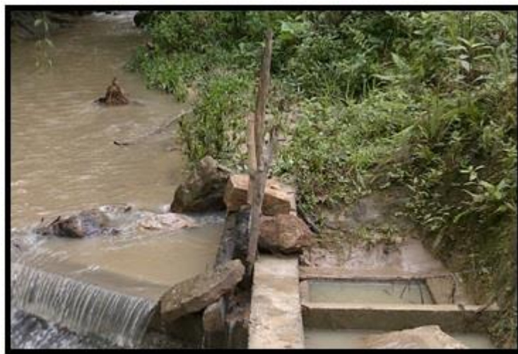
Foto 1: captación del agua
