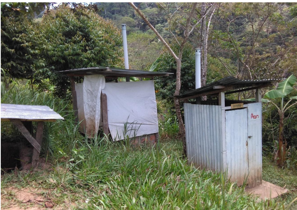
Figura 51. Letrinas instaladas en la mayoría de los hogares. Fuente. Fotografía tomada por el autor.
