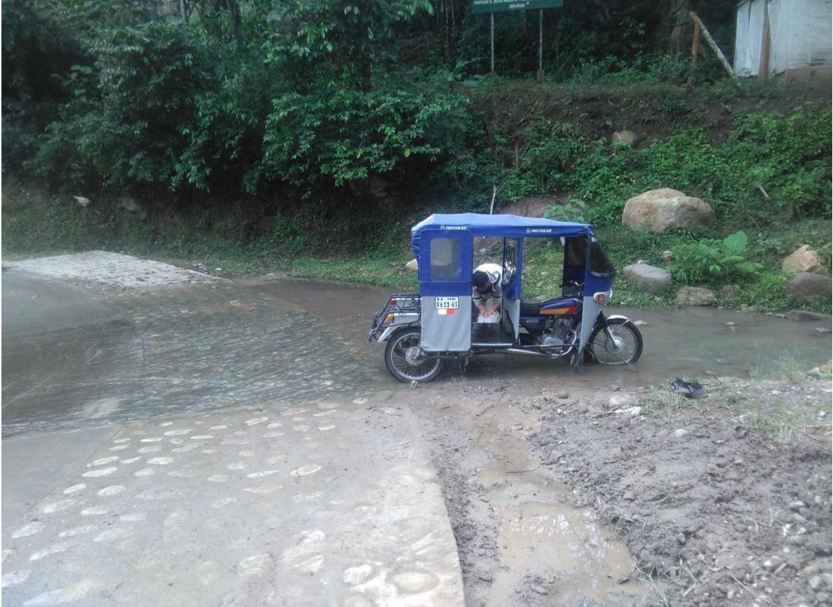
Figura 52. Badén, paso obligado al distrito de Jepelacio. Fuente. Fotografía tomada por el autor.
