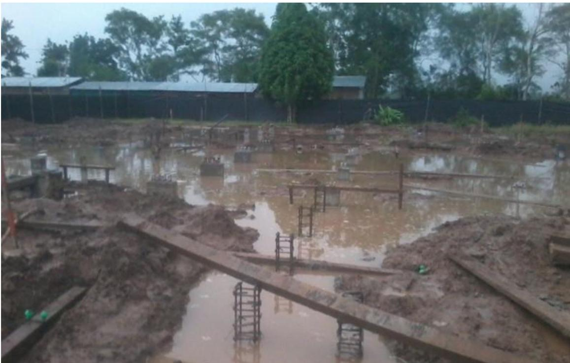
**Figura 4:** Se observa las inundaciones dentro de la obra con las avenidas del río mayo, por lo que se demuestra la necesidad de la elevación de la infraestructura.
