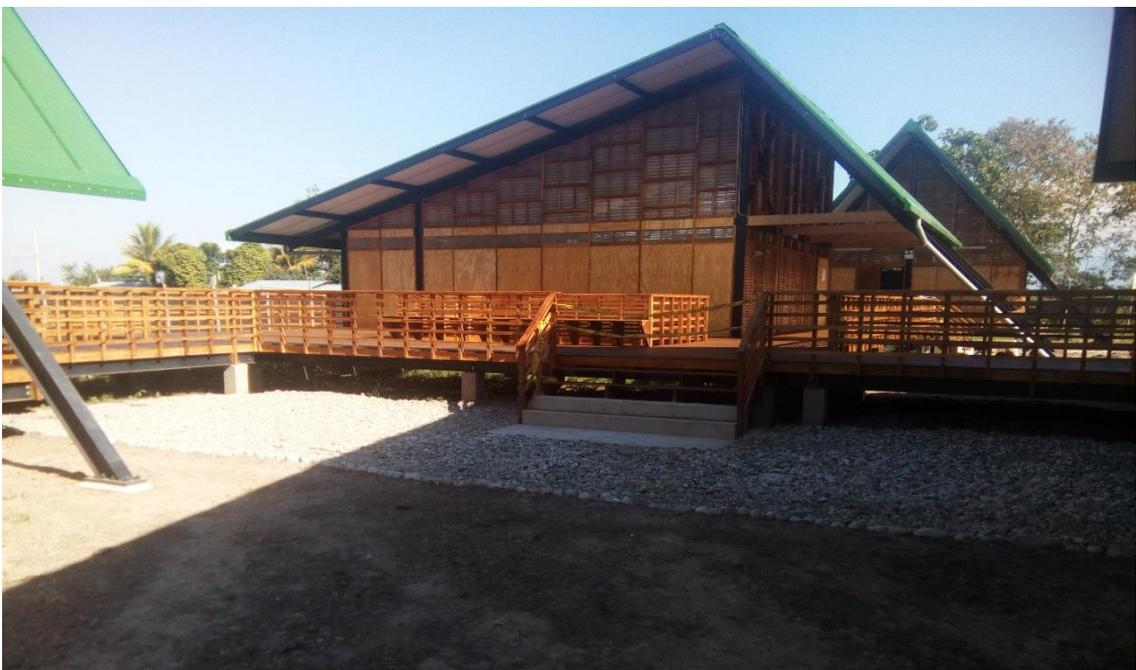
*Figura 2:* Aquí otra imagen donde se observa los trabajos terminados de la escuela, se observa las elevaciones con pilotes con fines de prevención de inundaciones.
