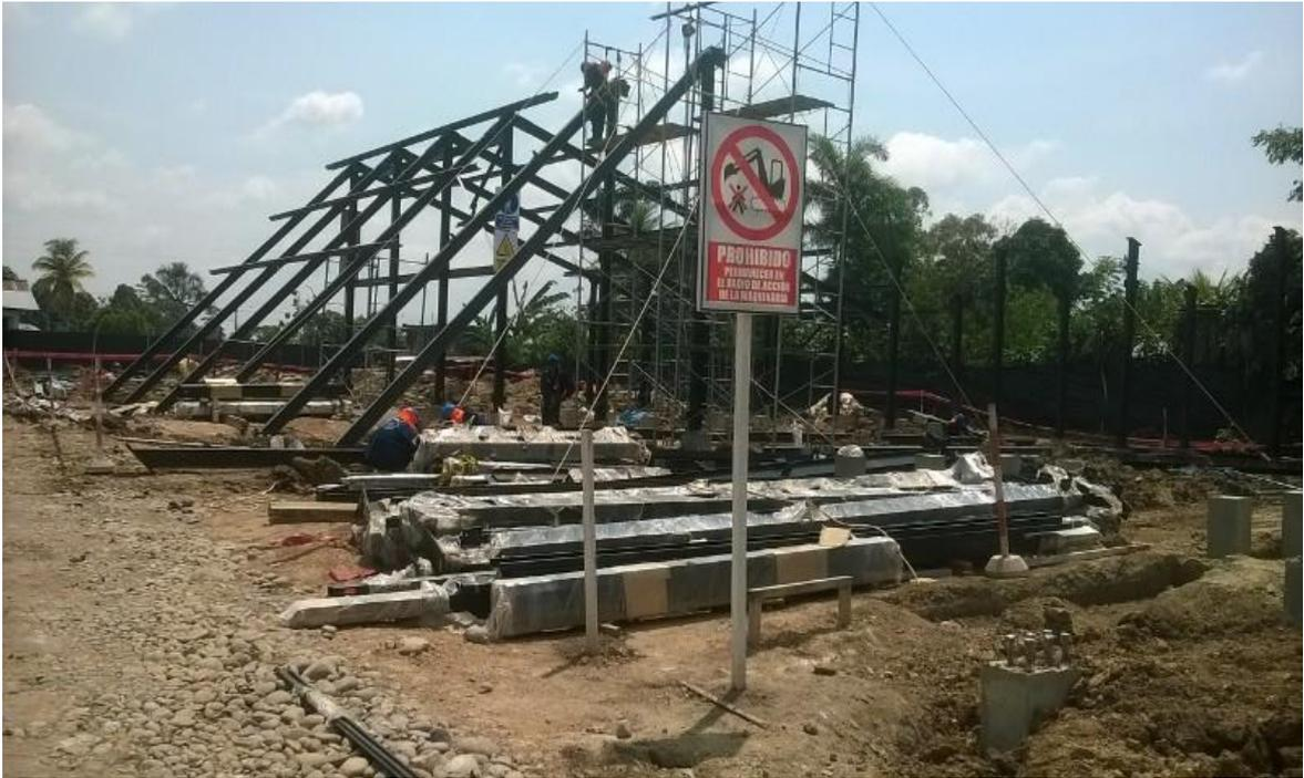
**Figura 5:** Se ve aquí el ensamblaje de los módulos metálicos que servirán de techo para los módulos ya mencionados.
