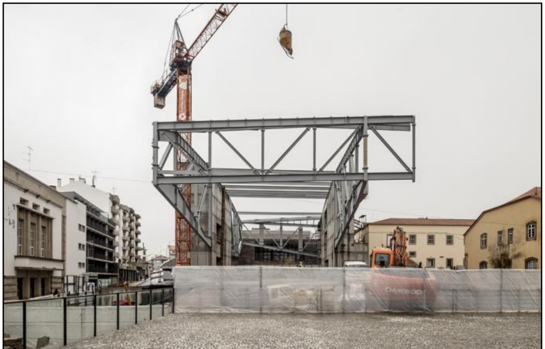
Montaje de la estructura. Centro cultural en Castelo Branco, Portugal.
