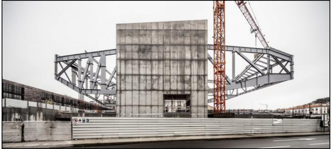
Proceso Constructivo C.C en Castelo Branco, Portugal.
