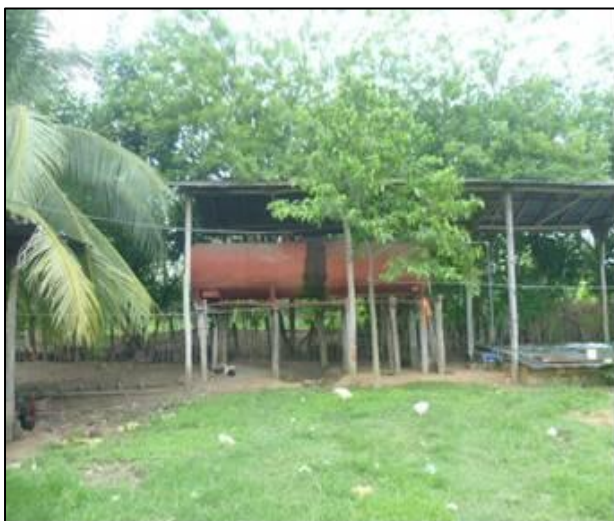
Foto 02. Tanque de agua que abastece al camal.
