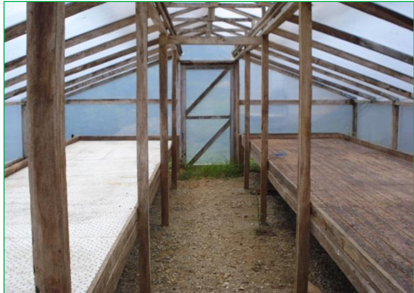
Figura 50: Interior de un secador natural tipo marquesina.
