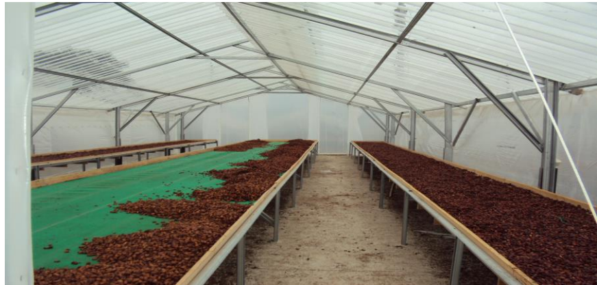
Figura 51: Parte interna del secador solar marquesina
