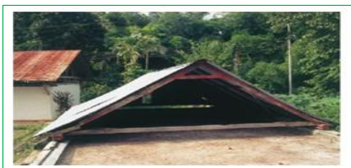
Figura 59: Secador de cacao: Patio de cemento con techo rodante.
