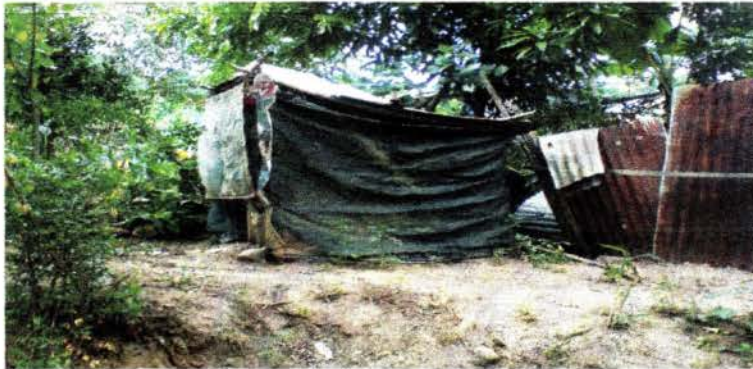
Foto N°02: Letrinas ubicadas en la parte alta Sector Venceremos.
