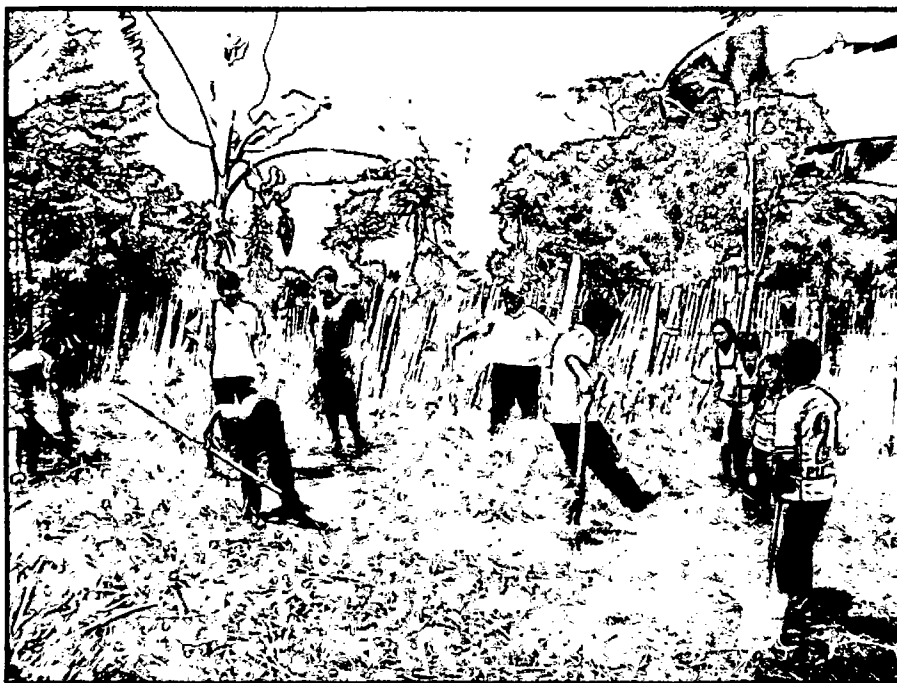
Limpieza del área donde se construye el centro de acopio para los residuos sólidos.
