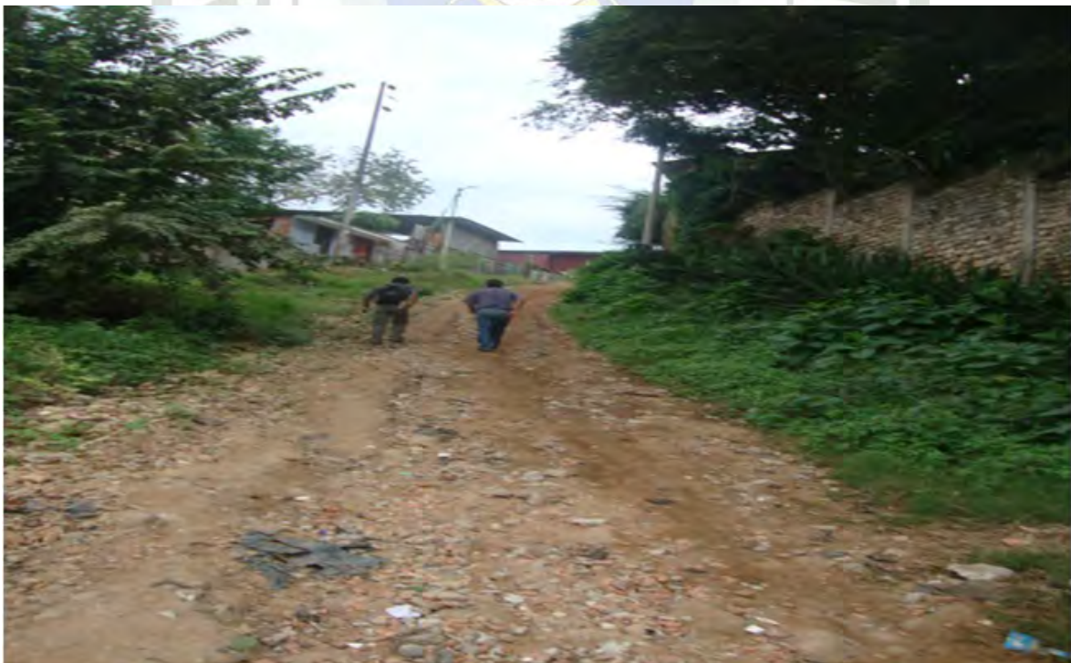
Obsérvese la construcción de viviendas en la zona de taludes en la última cuadra del jirón Santa Inés
