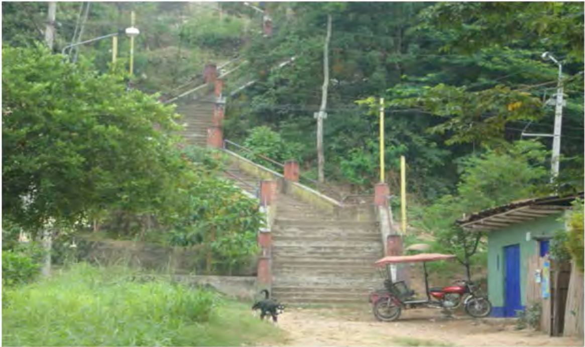
Obsérvese la construcción de viviendas en el pie de taludes en la última cuadra del jirón Progreso
