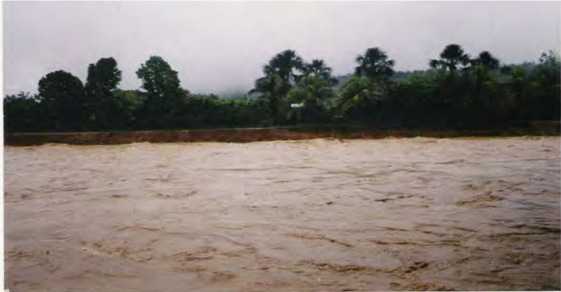
Imagen 3: Avenida extraordinaria del río Cumbaza, Aguas arriba del puente, erosionó y colapso la plataforma de la carretera Tarapoto-San Antonio de Cumbaza ubicada a la margen derecha del río, a la altura del AA.HH Cumbaza, del distrito de Morales, el primero de mayo del 2001 (Foto cortesía Ing. Ing. Rommel Ríos Córdova)
