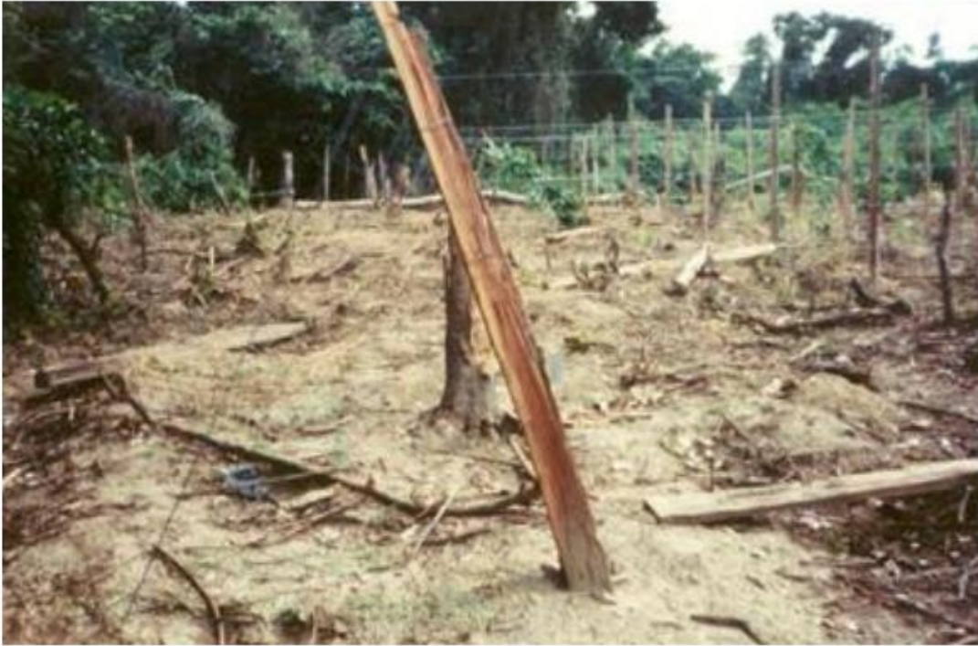
Figura 2. Instalación de "templadores" en sistema de espalderas Nota: Arévalo (1996)
