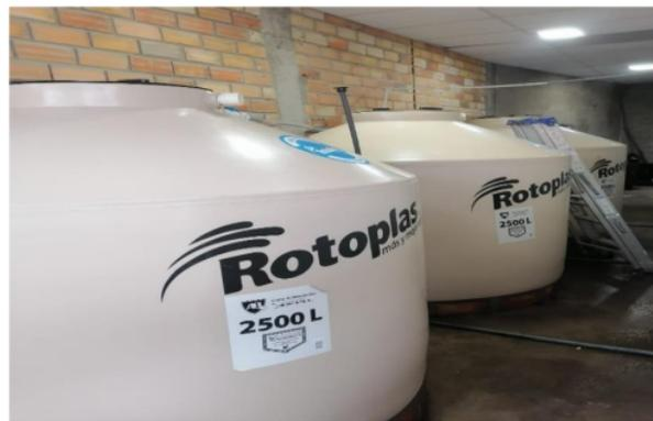
**Fotografía 2.** Tanques de almacenamiento de agua cruda de 2500 litros
