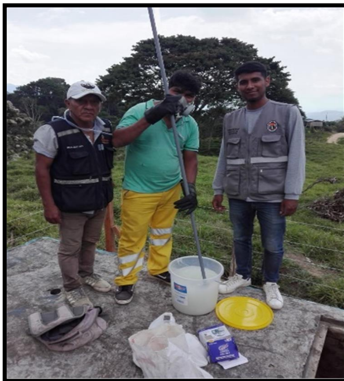
Fotografía 3. Preparación y disolución del Hipoclorito de calcio al 70% con agua.
