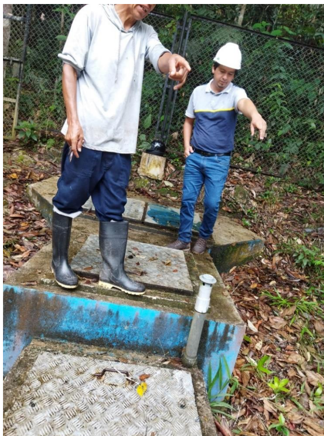
Fotografía 1. Recorrido de reconocimiento de la captación del sistema de agua potable de Marona.
