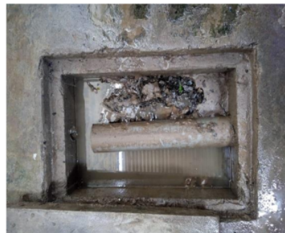
Foto N° 15: mantenimiento y limpieza del filtro, esta foto resalta la importancia de una limpieza eventual y programada del filtro para evitar su saturación y baja eficiencia
