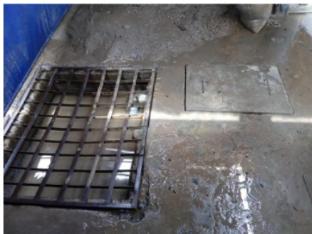
Foto N° 14: mantenimiento y limpieza del sistema; en la parte superior al fondo, se puede observar el lodo retirado de la trampa de grasa
