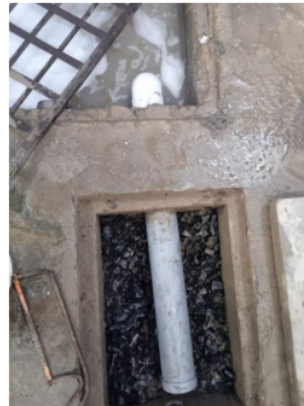
Foto N° 15: mantenimiento y limpieza del filtro, esta foto resalta la importancia de una limpieza eventual y programada del filtro para evitar su saturación y baja eficiencia
