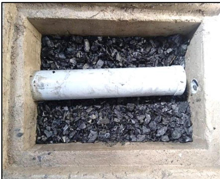
*Figura 7.* Filtro de grava, arena y carbón activado
