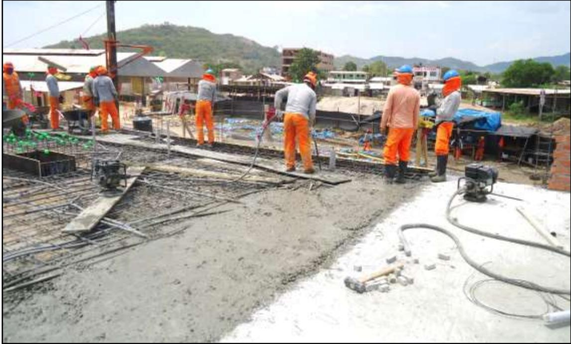
*Imagen 1.* Losa vaciada por sectores, en función al área de los lotes.
