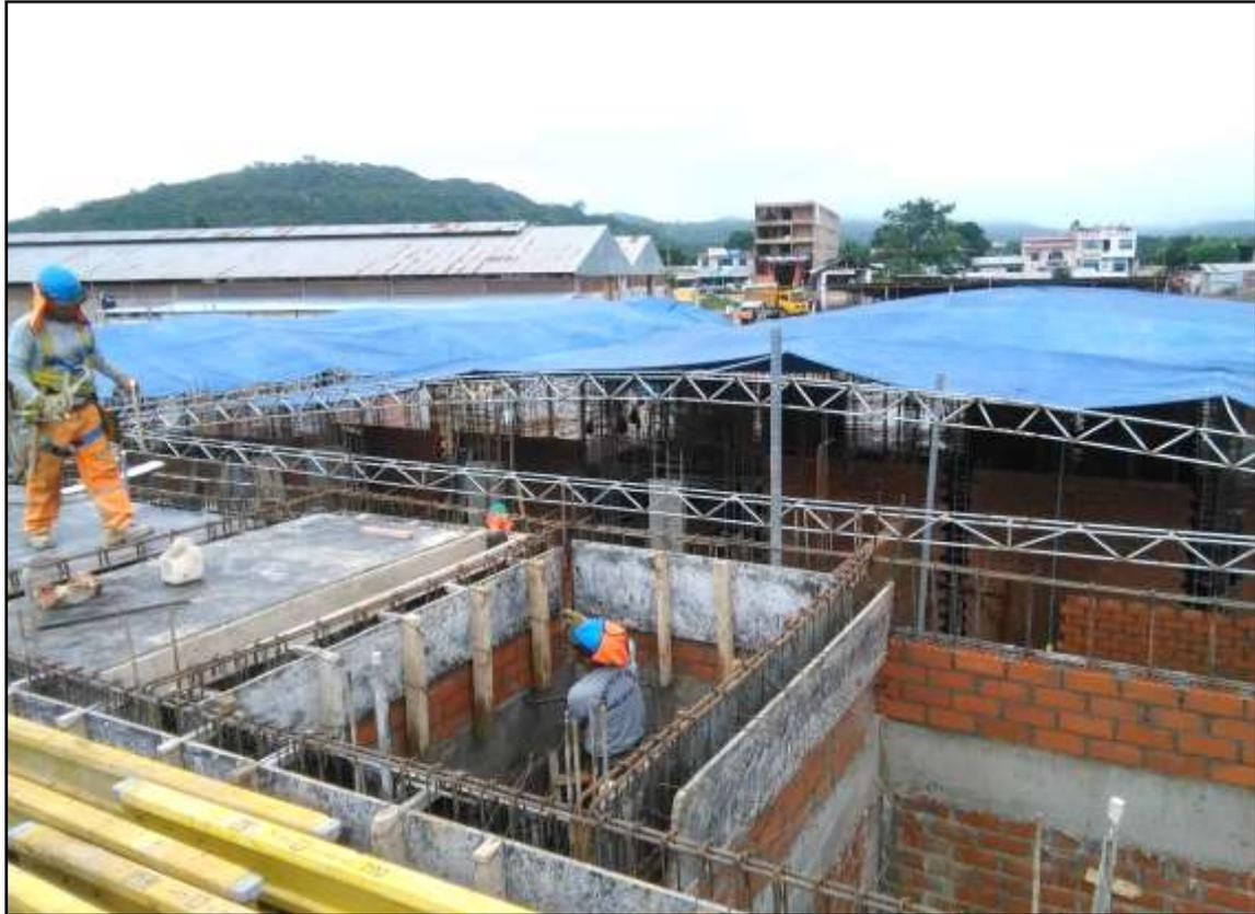
*Imagen 2.* Protección con toldos para controlar la variabilidad por lluvias.
