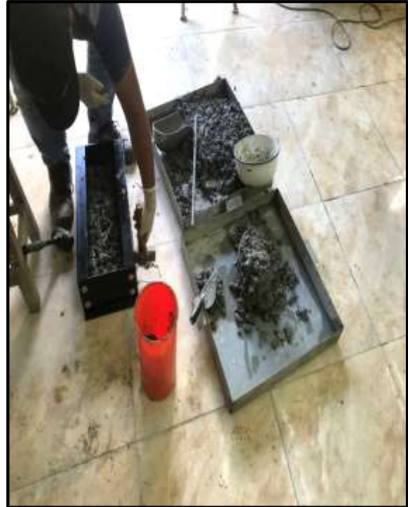
Foto 100: Procedemos al llenado de la viga siguiendo los mismos pasos de las probetas.
