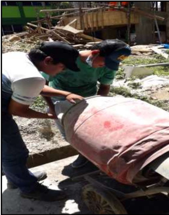
Foto 51: Segundo se ingresa el agregado grueso un 50%.
