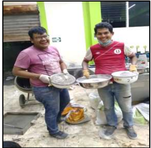
Foto 68: Separamos la ceniza de cascarilla de arroz para agregar por dosificaciones.
