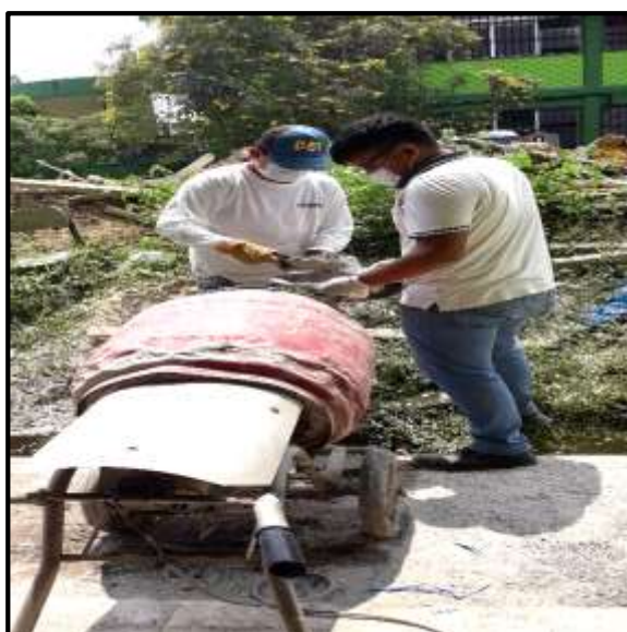
Foto 81: Ingresamos los agregados al trompo para obtener la mezcla.
