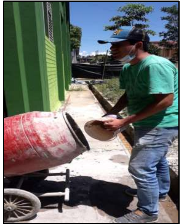
Foto 52: Tercero se ingresa el 50% del cemento.
