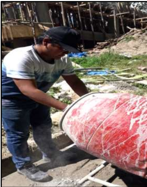
Foto 53: Luego se coloca el 50% del agregado fino.
