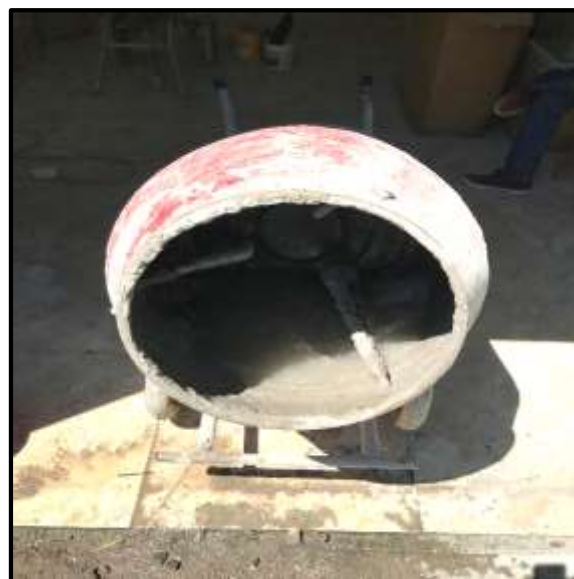
Foto 50: Primero se humedece el trompo con el 10 % de agua.
